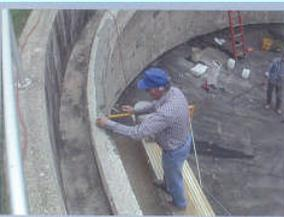
この1939年に建造された屋外排水処理タンクは、約20年補修されていない状態でした。露出した鉄筋及び腐食と破損箇所は修理が必要でした。
