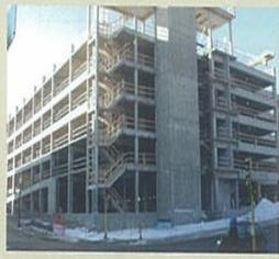
1,800台入る6階建て駐車場は22,000立方ヤードのコンクリート全てを18~24時間以内に3,000psi以上の強度にする必要がありました。亜硝酸カルシウムベースの防錆剤は24時間以内では最小限の強度に見合わず、収縮ひび割れも発生しました。MCI-2005NSは要求スペックに見合い、30%も収縮を減少させ、0°C以下でも収縮ひび割れを抑えました。
