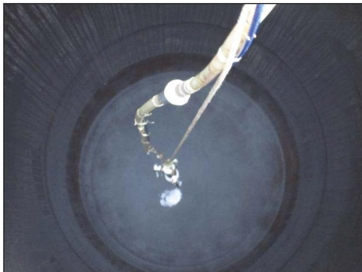
パイプにVpCl®-609S（生分解性粉末）を適用します。
