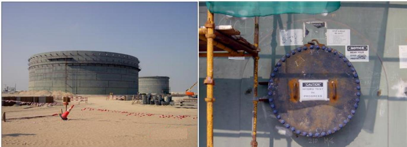
コーテックは、この防錆システムを、海水を使用した静水圧試験にかけられた炭素鋼タンクの内部を効果的に腐食保護し、しかも、経済的で環境に配慮した方法として提案しました。
