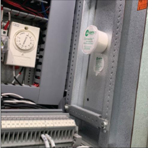
ある自治体の廃水処理施設では、市内のポンプ場で高価なHMIパネルが頻繁に故障（タッチパネルの交換は約15,000～40,000ドル掛かる）していました。解決要望に含まれていたのは、パネル内の電圧変化を最小限に抑えること、機器の電源を切った後にエレクトリコアVpCI®-239を軽くスプレーすること、及び、パネル内にコロソーバー（腐食性ガス吸着防錆剤）とVpCI®-111（カップ型防錆エミッター）を置くことが含まれていました。これらの定期的なメンテナンス手順を採用することで、交換頻度とコストが大幅に削減され、投資収益率が大幅に向上しました。
